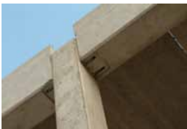
Pilar e Viga
