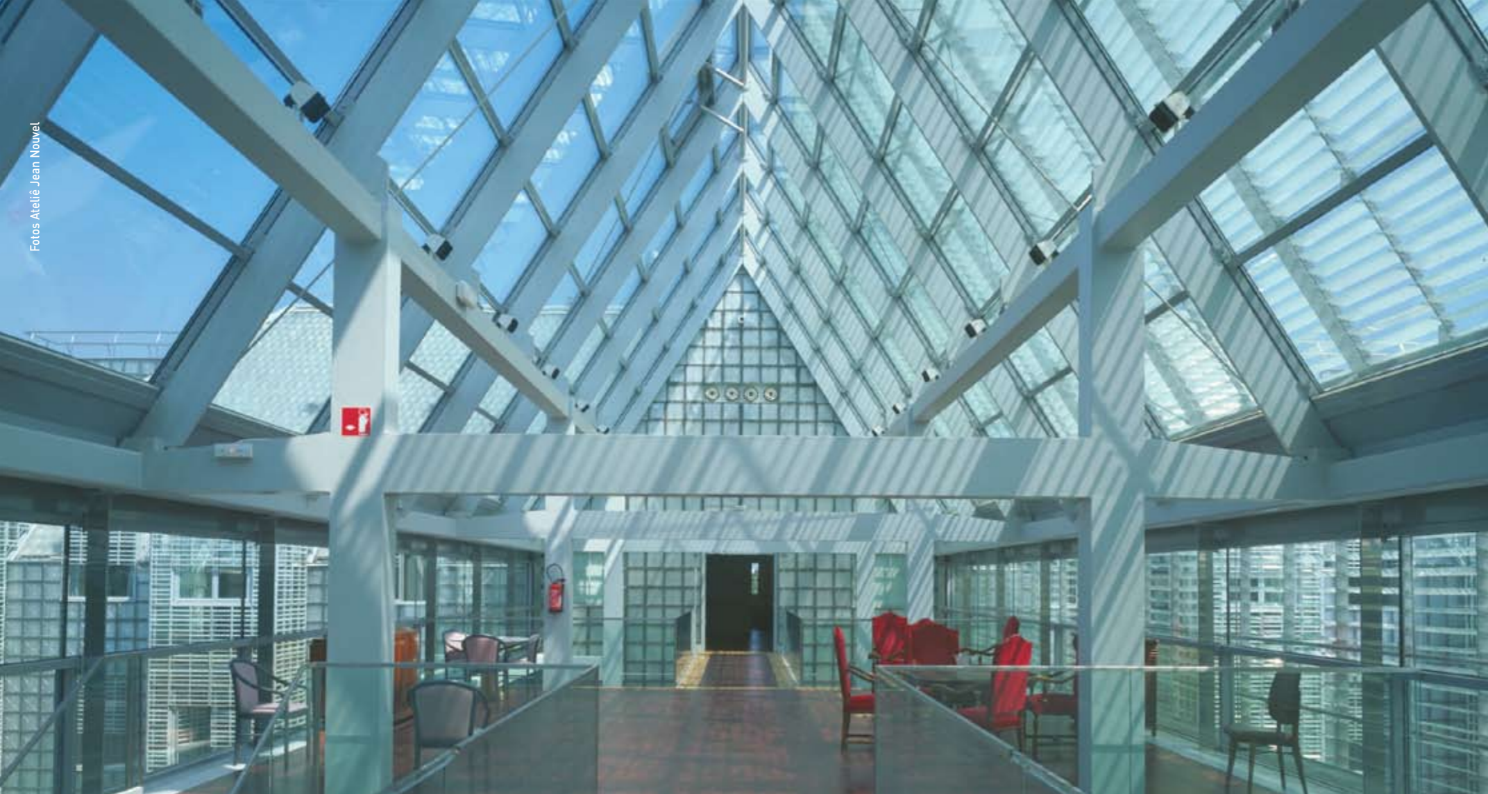
A união dos blocos de vidro com o aço galvanizado trouxe leveza e clareza ao interior da Fundação Cognacq-Jay, em Paris. Construída no século 19, a casa principal ganhou dois novos anexos, projetados pelo escritório do arquiteto francês Jean Nouvel
