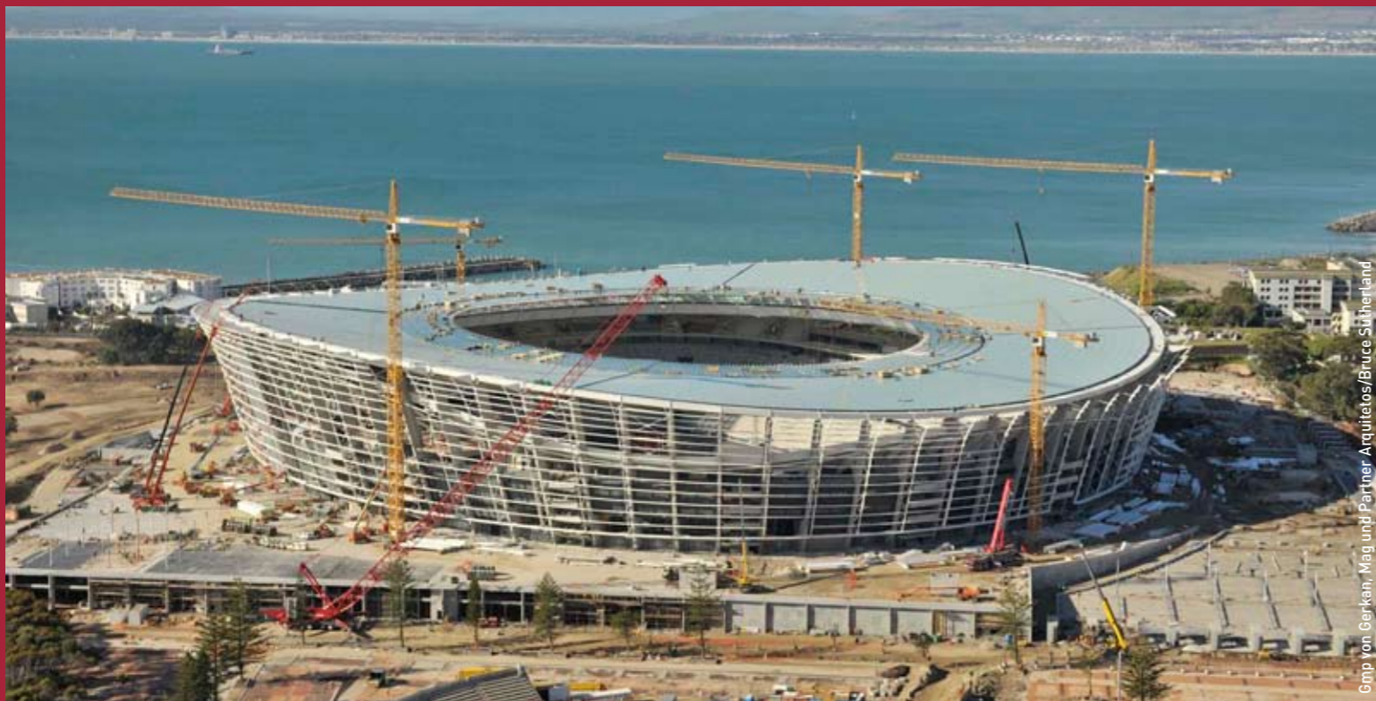
Acima, obras no Estádio Greenpoint, palco de uma das semifinais da Copa do Mundo de 2010. O anel externo sozinho leva mais de 1,6 mil toneladas de aço. Abaixo, o Soccer City, com design influenciado por uma argila africana. Treliças de aço sustentam a cobertura do estádio, reformado para o evento
