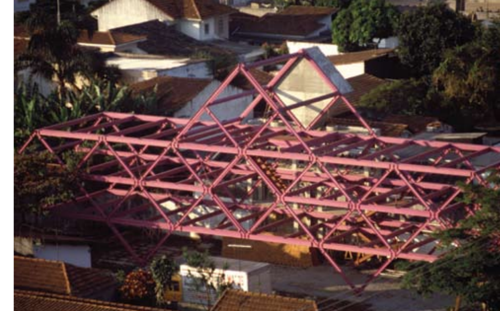
Acima, o estúdio do arquiteto durante as obras, na capital paulista: inteiro executado em estruturas pré-fabricadas. Abaixo, vista aérea do Cenpes: canteiro de obras limpo, organizado e silencioso
