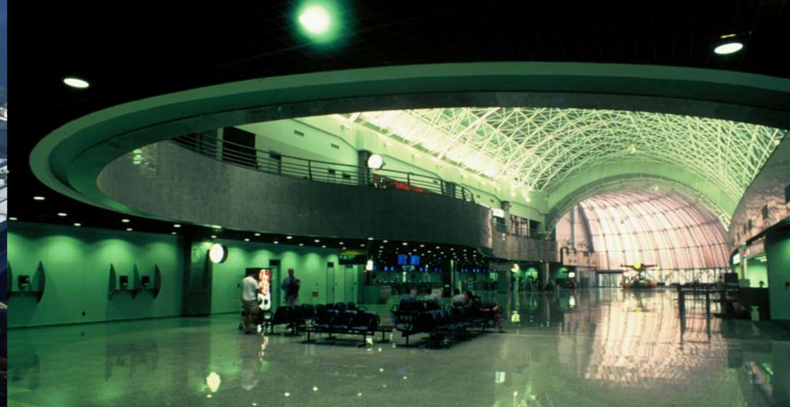
No aeroporto de Fortaleza (acima e abaixo), uma malha curva cobre o vão central. As obras da construção de quatro andares foram realizadas em dois anos, sem impactar o edifício vizinho, um prédio dos anos 1960
