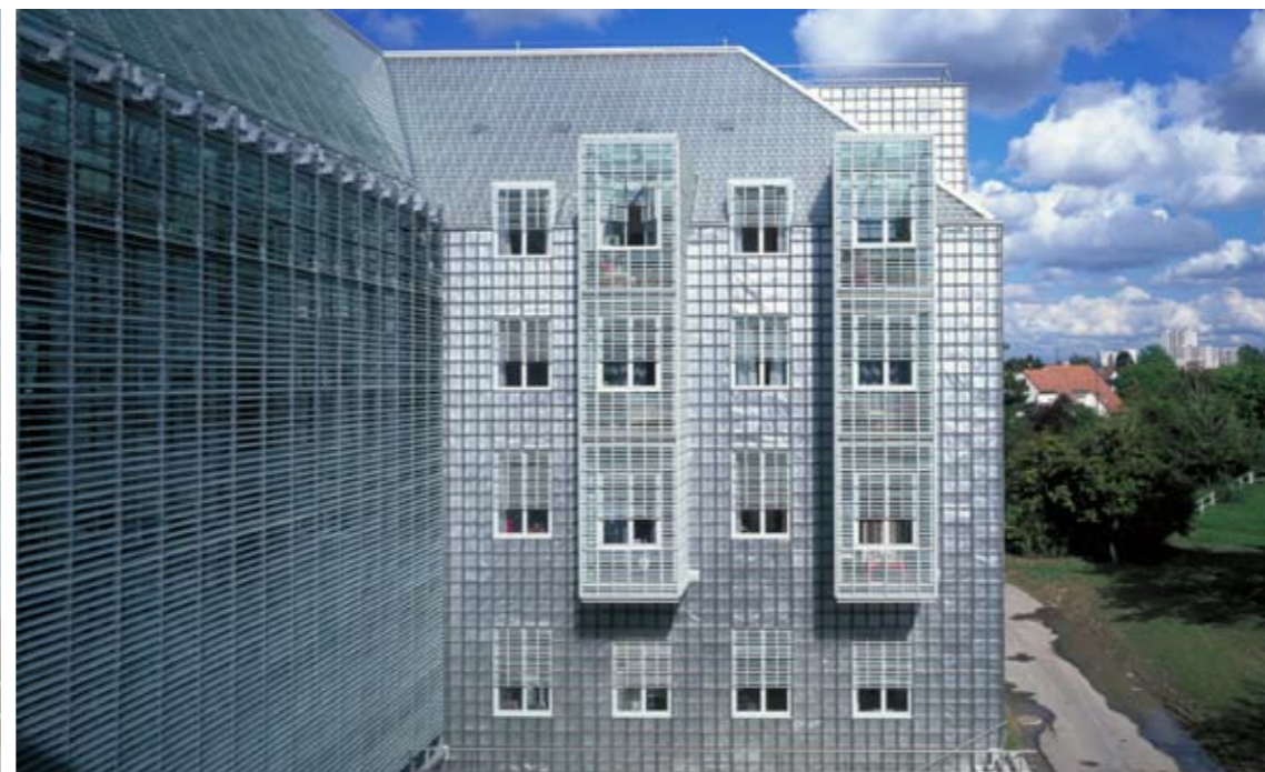
A união dos blocos de vidro com o aço galvanizado trouxe leveza e clareza ao interior da Fundação Cognacq-Jay, em Paris. Construída no século 19, a casa principal ganhou dois novos anexos, projetados pelo escritório do arquiteto francês Jean Nouvel
