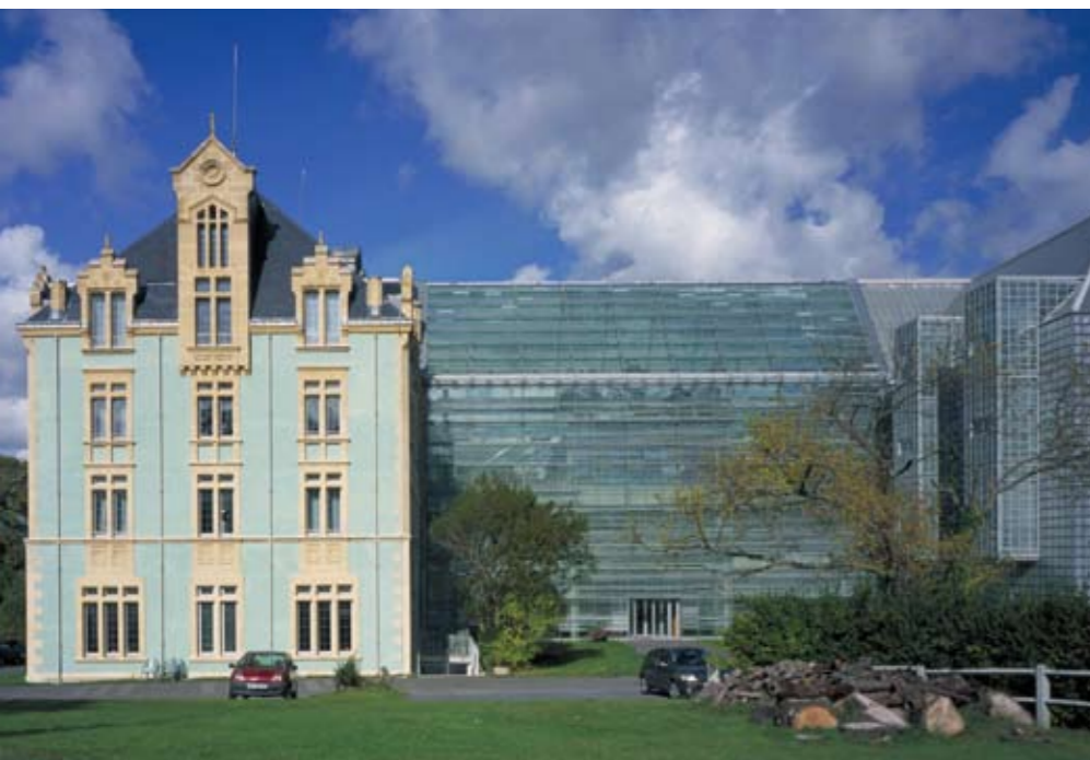
A união dos blocos de vidro com o aço galvanizado trouxe leveza e clareza ao interior da Fundação Cognacq-Jay, em Paris. Construída no século 19, a casa principal ganhou dois novos anexos, projetados pelo escritório do arquiteto francês Jean Nouvel
