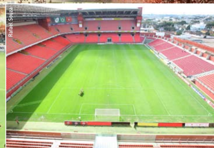
Em 1998, em Curitiba, nasce a primeira cobertura em aço para os estádios de futebol no Brasil. Precursora, a Arena da Baixada ganhará cobertura para 100% dos assentos
