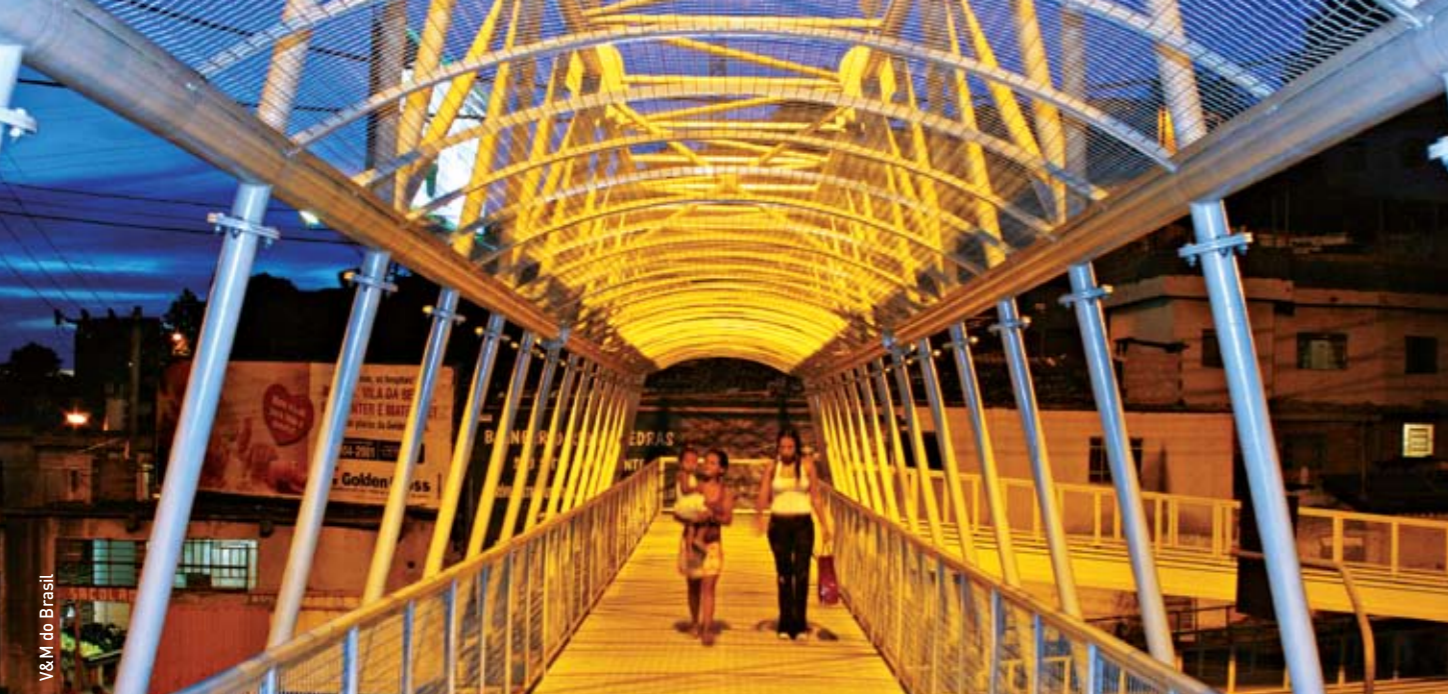
A passarela Belvedere dispensou a fixação de apoios no canteiro central da avenida Nossa Senhora do Carmo, em Belo Horizonte. Os tubos estruturais são visíveis em toda a construção
