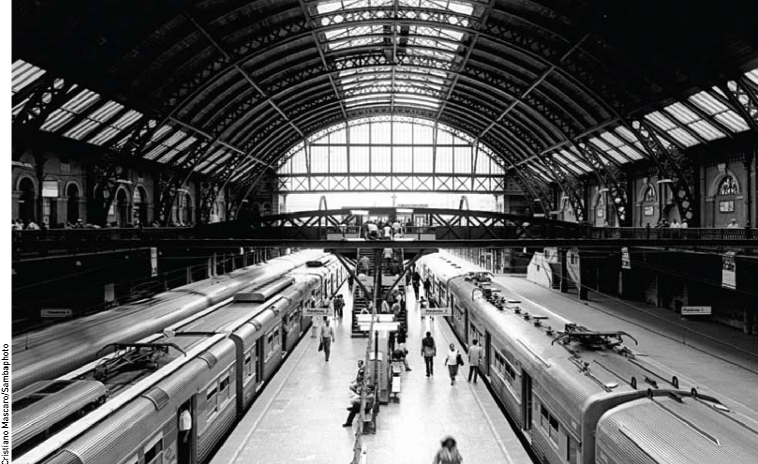
A primeira cobertura em aço da cidade de São Paulo foi construída em 1901, na Estação da Luz (acima). Os arcos treliçados restaurados em 2005 vencem o vão de 39 m do terminal de passageiros. Em construções mais recentes, como a estação de metrô Alto do Ipiranga (abaixo) as coberturas metálicas também são uma opção para acelerar o prazo de execução da obra e incorporar a paisagem urbana ao projeto
